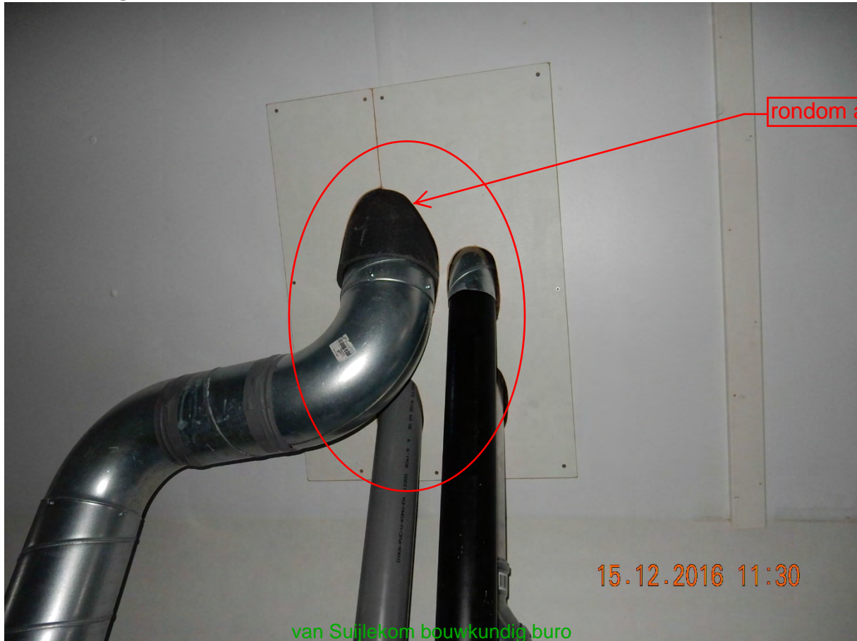
Figuur 1 Zolder dak doorvoeren installaties
